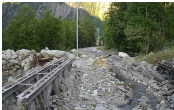
Figura 42: Esempio di colata detritica su una strada regionale dovuta allo svuotamento improvviso di una sacca d'acqua del ghiacciaio del Rochefort (©Regione Autonoma Valle d'Aosta)
